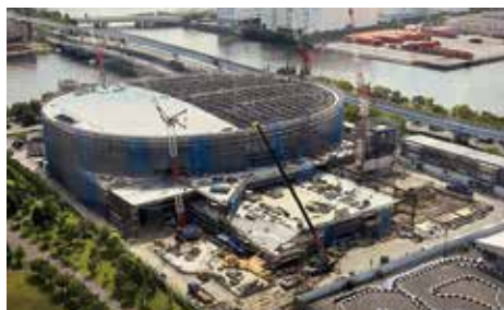
工区を南北に分け、写真左側の北工区からダブルバックを施工。南工区は鉄骨にタイトフレームを設置中
