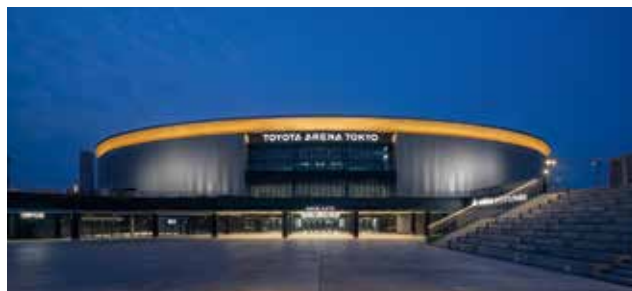
3階「GATE PLAZA」からメインエントランスを眺める。頂部の庇がライトアップされビーコンをイメージした外観を引き立てている
