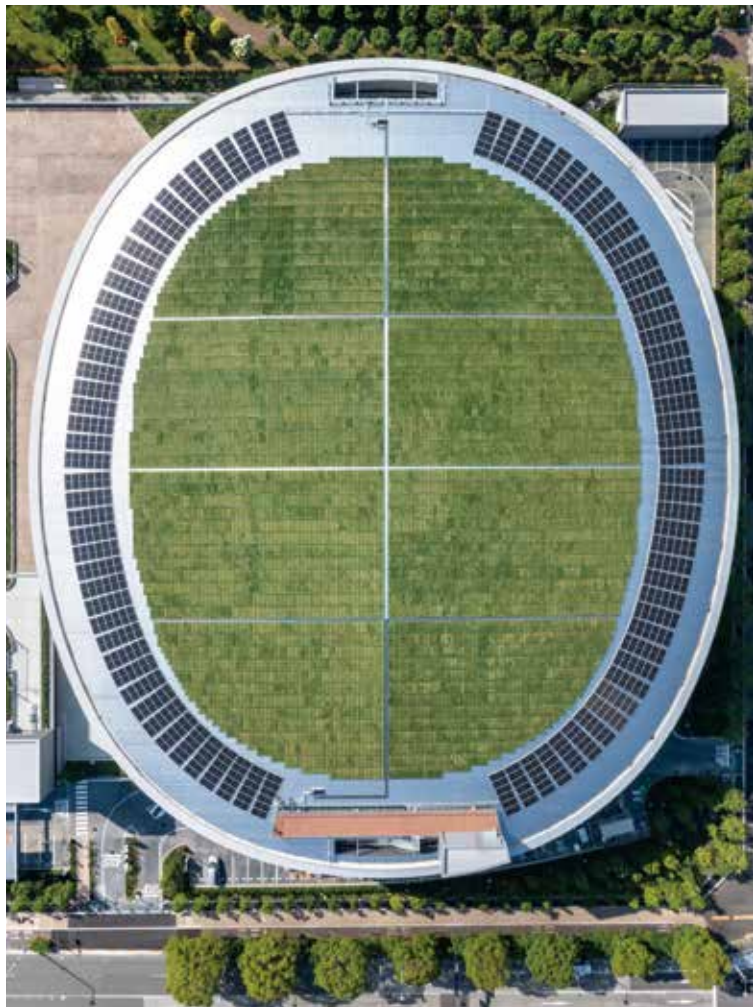
上からの眺め。写真上が北。屋根は南北120m、東西100m。屋上緑化面積は国内のアリーナ施設の中で最大級。ユニットグリーンシステムの外側はソーラシステム。楕円の円周は360mで、谷樋が縁取る
