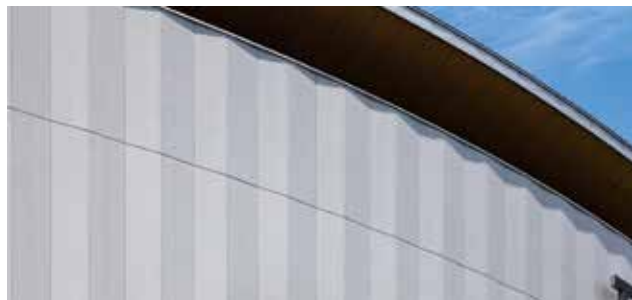
屋根の木口は屋根勝ちの唐草納め。外壁は凹凸のある押出成形セメント板で陰影をつけている
