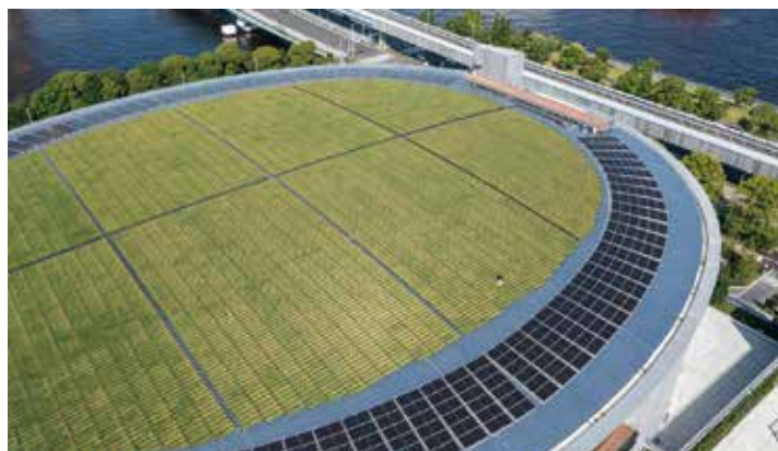
ユニットグリーンシステムの施工がほぼ終了。右の茶色の部分は展望デッキ
