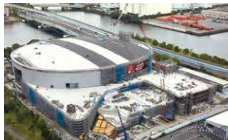
北工区はR-T工法が終わり、南工区はR-T工法の下地ができたところ
