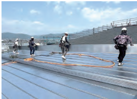
揚重した長さ15mの屋根材を数名で運ぶ。多い時は1日25名くらいが作業に当たる
