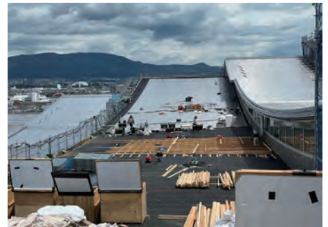
段状になった屋根を1段飛ばして作業していく。真ん中部分は、雨水が軒先に流れるように、木下地を組んで勾配をつくっている
