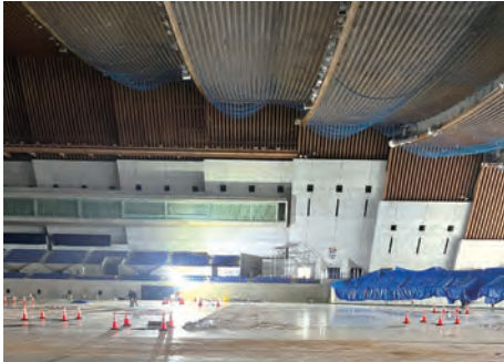
アリーナ内部。天井部分に落下防止ネットが設置され、安全対策が取られてから、屋根工事がスタート
