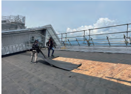
解体作業。新築時のルーフィングをはがすと下地の構造用合板が現れる。合板に腐食がないかも確認
