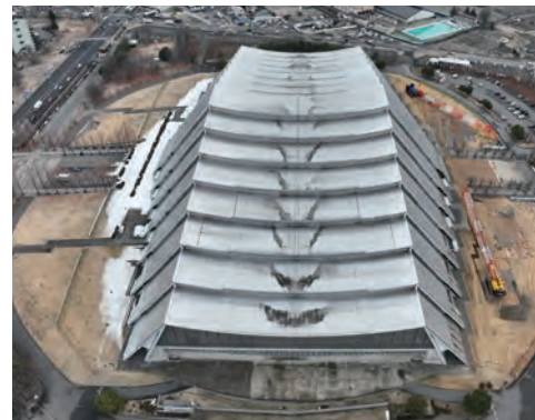
↑改修前（西側上空） 短手方向に平行に屋根が葺かれている。水が溜まりやすいM型架構の中央部が黒くなっている
