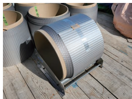
深谷製作所から届くコイル。現場を実測してから発注（オーダー）する
