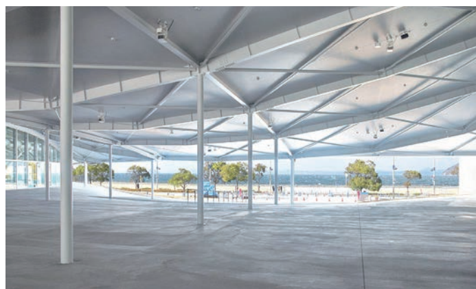
メインエントランスは 24 時間通行可能で海側の広場に抜けられる
