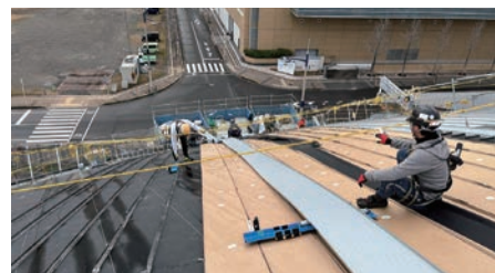
南側の成型機から出てくる屋根材を葺く様子を上から見る
