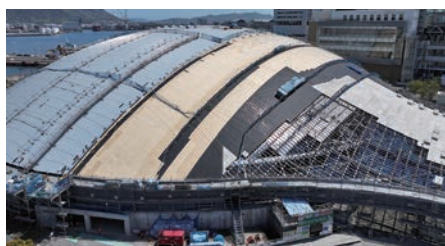
北側（海側）に成型機を置いてメインアリーナの西側に屋根材を設置していく
