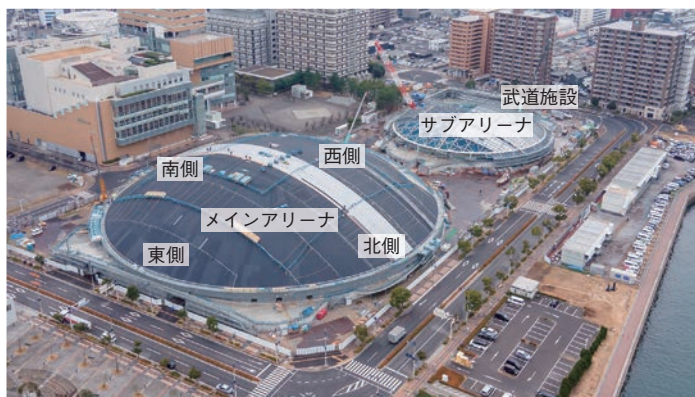
建設中の様子。大小の円はメインアリーナとサブアリーナ。メインアリーナに屋根材を葺き始めて間もない頃
