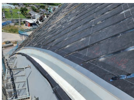
寸法の違うキャンバーを施したものを合わせながら割り付けをする
