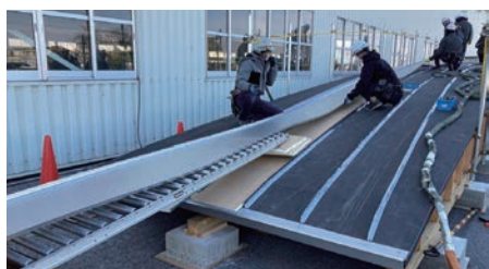
深谷製作所で屋根材のモックアップを作成
