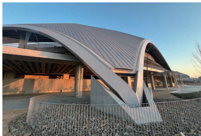
軒樋の着地点と集水枡
