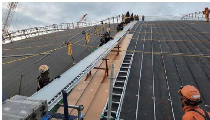
1枚目の作業の様子。南側に置いた成型機から屋根材を引き出して葺いていく
