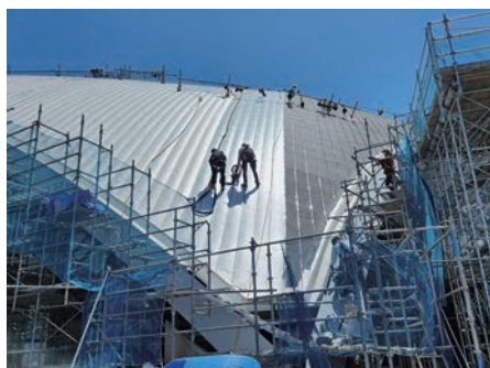
樋の着地点近くの施工。急勾配での溶接
