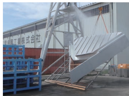
樋と集水枡の着地点。深谷製作所で耐性の実験
