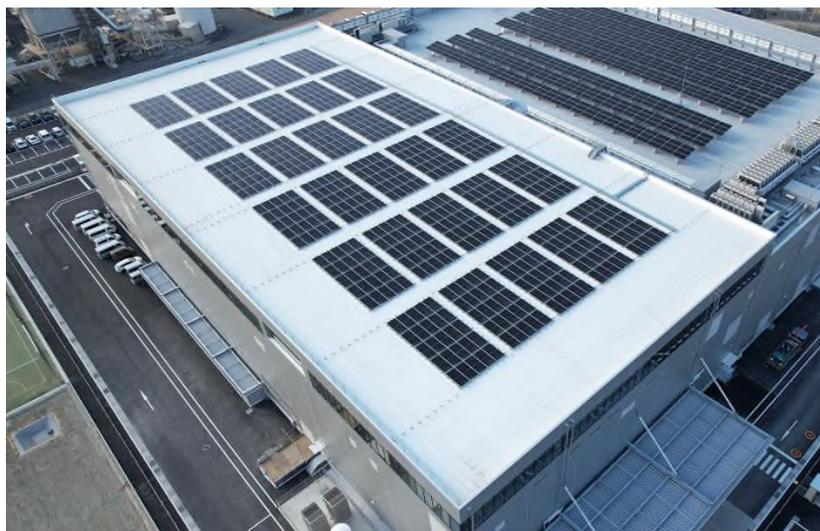
ハイタフEG屋根面積:5,264㎡、ソーラーフレーム長さ:2,876m、太陽光パネル:442kW
