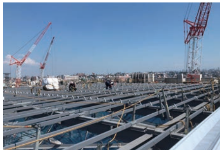
組み上がった鉄骨にタイトフレームを設置
