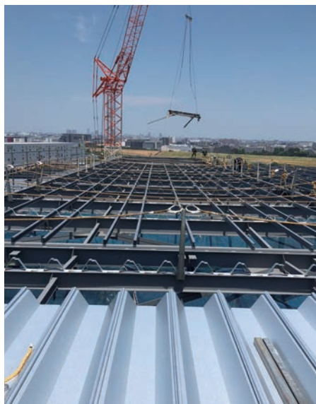
下弦材の工区境。クローラクレーンで下弦材を揚重
