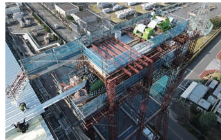
2層の移動構台。上階に材料をセットするアンコイラーと切断機が並び、下階から成型された材が屋上に引き出される（写真上）。下階の成型機（写真下）
