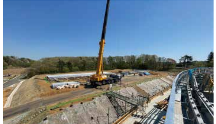
広大な敷地に屋根材の成型スペースを確保
