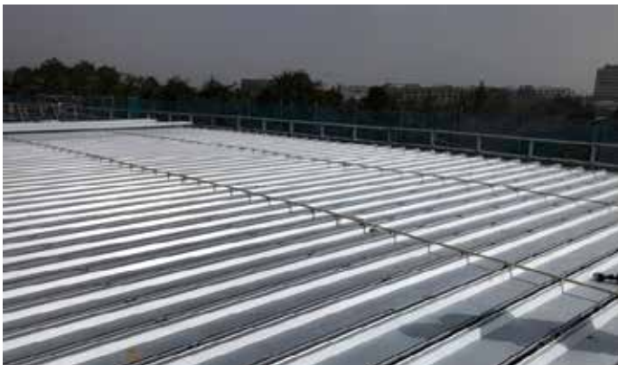
屋根(下弦材)の上にレール状のものを付けて、荷揚げした屋根材を滑らせて運ぶ
