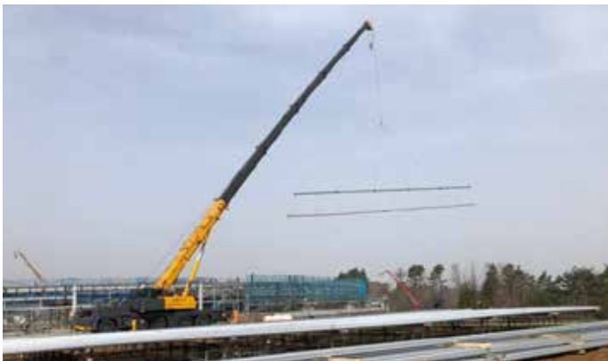
クレーンで屋根材を吊り上げる
