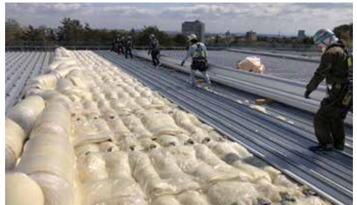
敷き込んだ断熱材の上に上弦材を葺く様子
