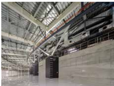
蓄積リングトンネルの上にV字状の柱が下りる
