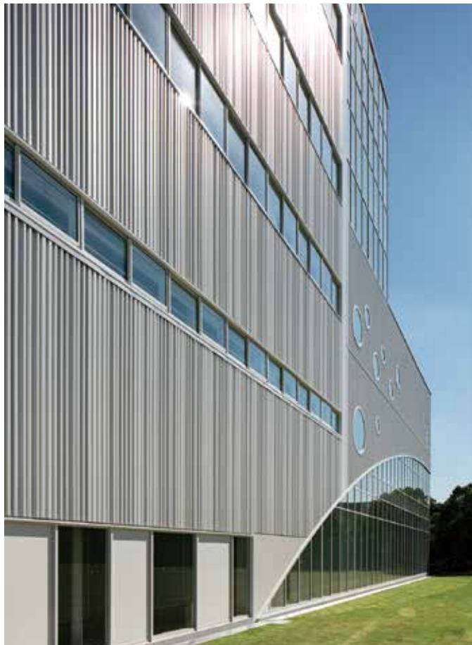
体育館棟の外壁は白い3種類のハイシャドーをランダムに張って表情に変化を付けている
