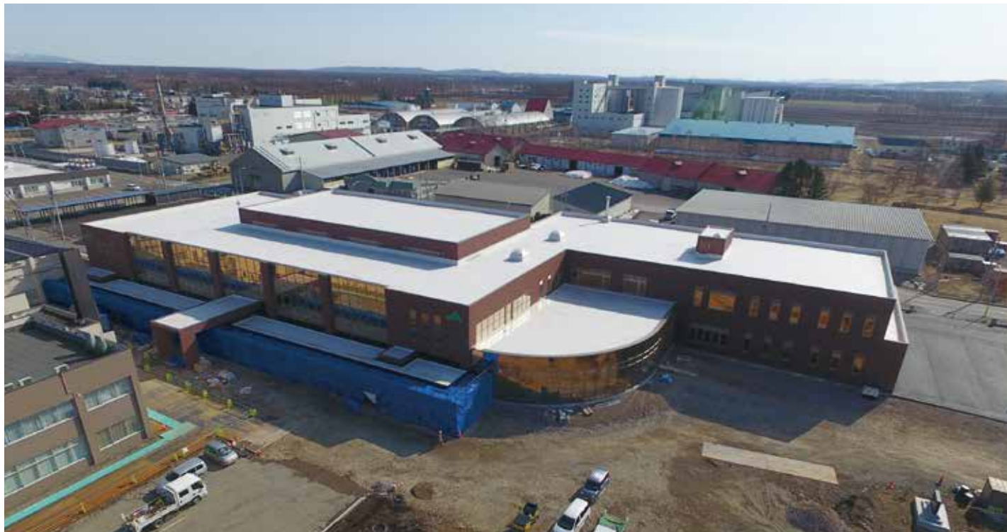
5,000㎡以上の広大な陸屋根に施されたエクスロン防水
