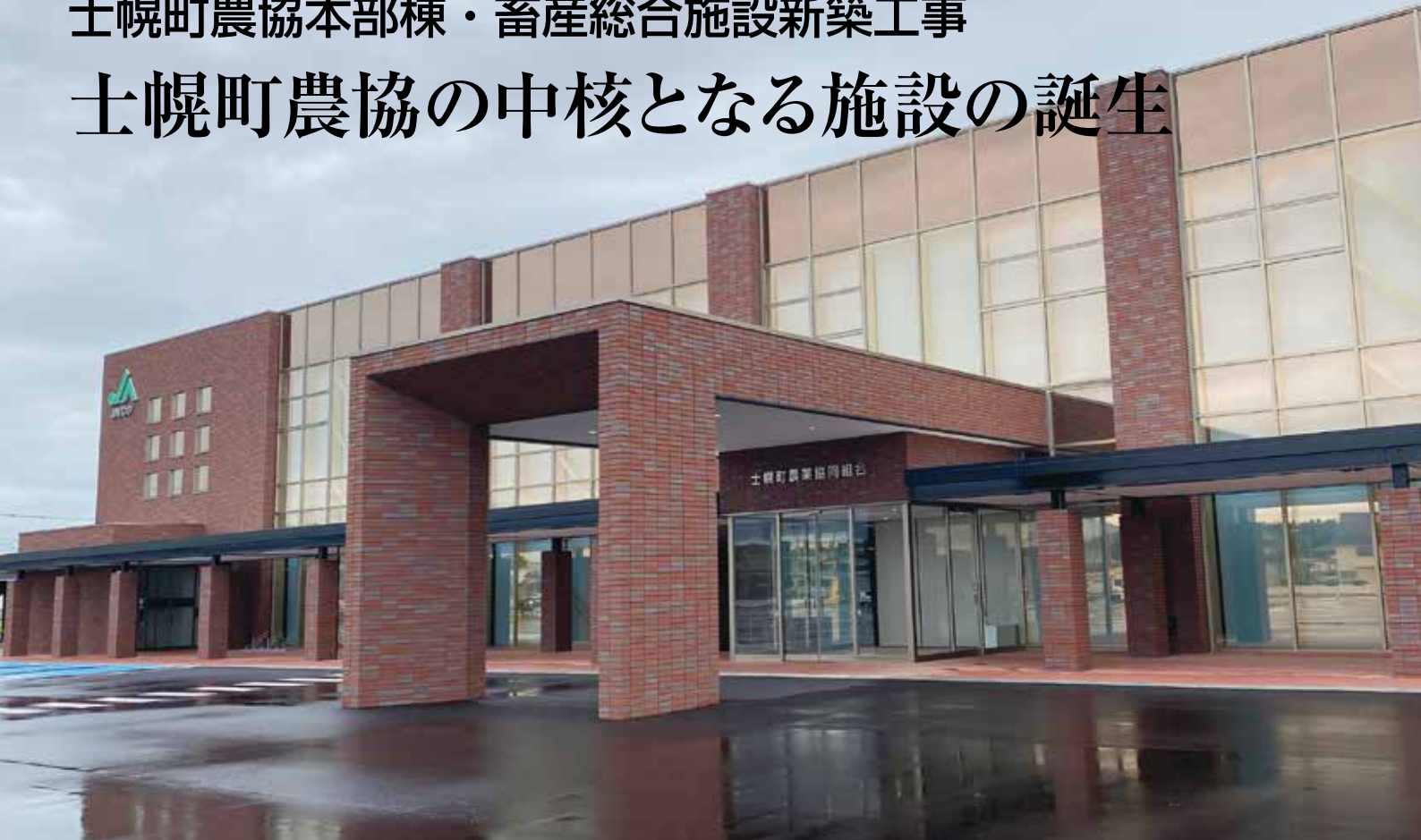
外観 士幌町の土の色をイメージした煉瓦と巨大なカーテンウォールで構成されたファサード
