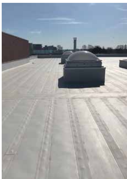
コンクリートスパイクを200mmピッチで打ち、留める
