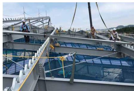
現場成型して屋根材(丸馳I型)を乗せる作業中
