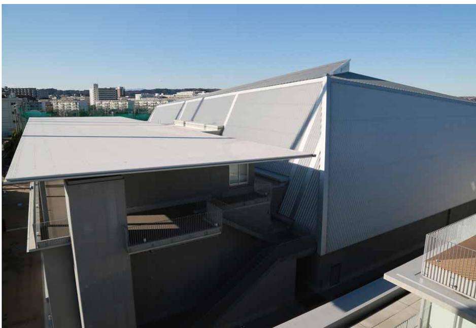
屋内練習場のW-500の屋根面に接する管理棟はハイタフEGで施工。長い庇の下に心地よい空間を作っている
