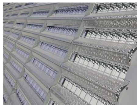
中央の青く見えている箇所がポリカ折版。上に穿孔折版を取り付けるため、周辺はW-500で施工している
