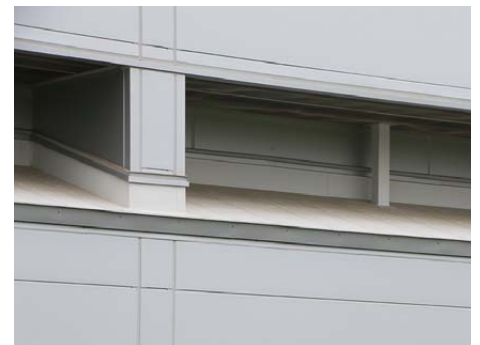
キュアリング室の換気のために設けられたスペースでは柱まわりもイソバンドで施工
