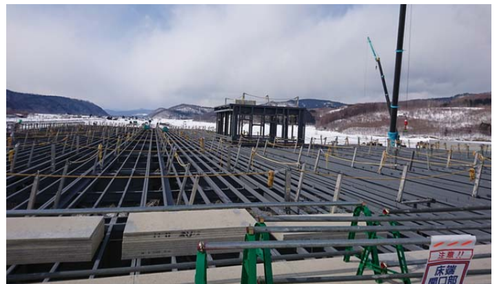
屋根工事が始まった頃
