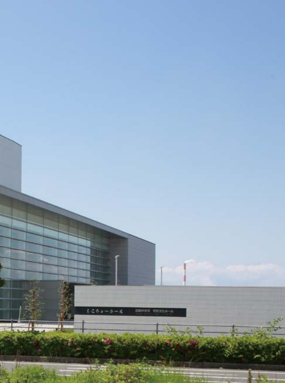
南東側からの景観
