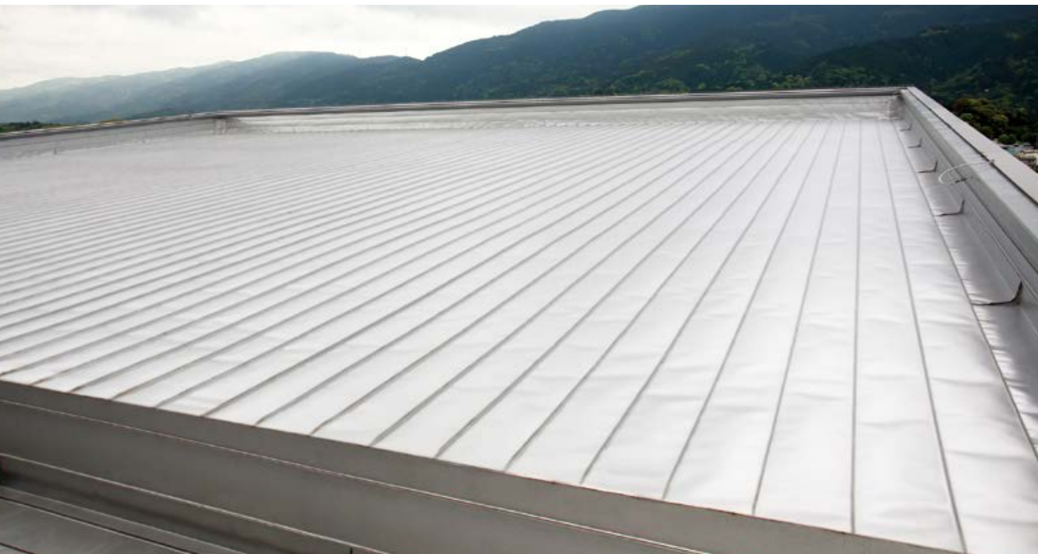
逆勾配の屋根をR-T工法で施工。手前が大きなR-T工法の樋の部分
