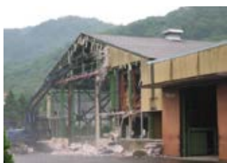
(a) 壁材の撤去
