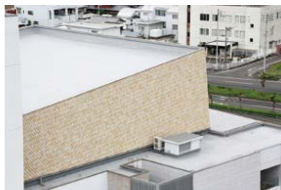
R-T工法で施工した客席上の屋根
