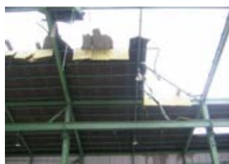
(b) 屋根材の撤去
