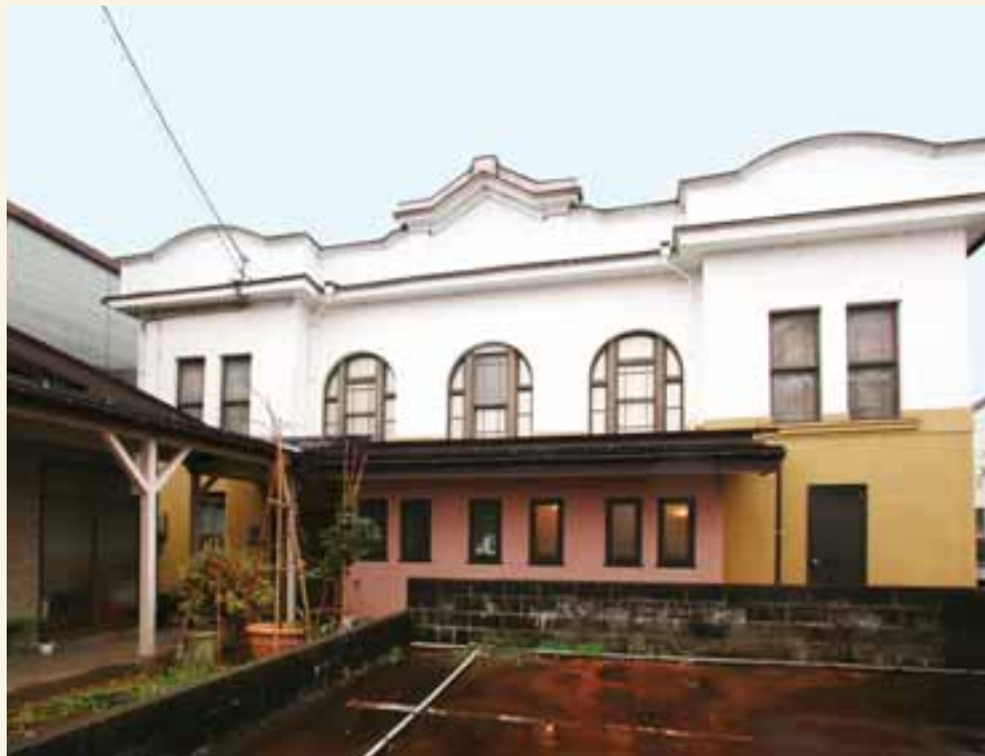
建物正面。左側に写る屋根付き通路が、表通りからのアプローチ
