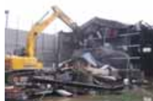
図2 機械切断工法
