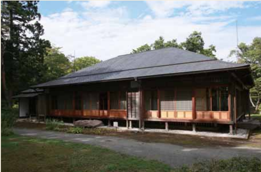
屋根の線は柔らかく、いかにも妃殿下の館の風情
