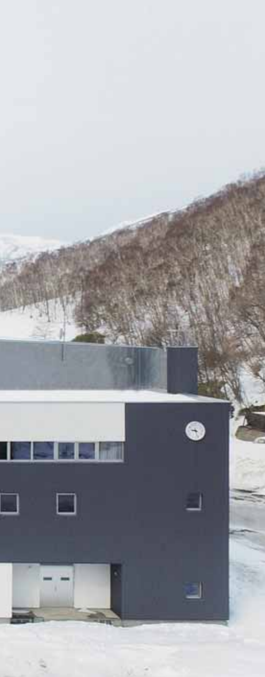
正面海側全景。屋根のシルバーの部分をR・Tで施工
