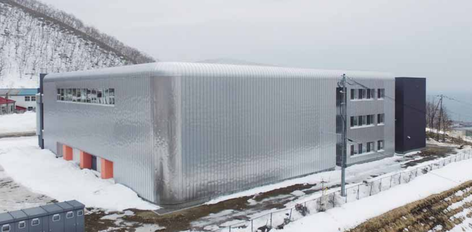
シェルターのような風貌の山側。強い風を防ぐため、ステンレスで屋根壁を一体で施工
