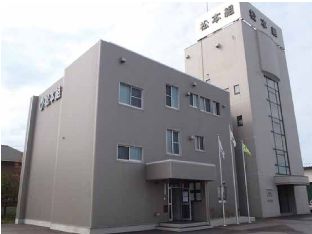
㈱松本組社屋耐震改修工事 （北海道函館市）
