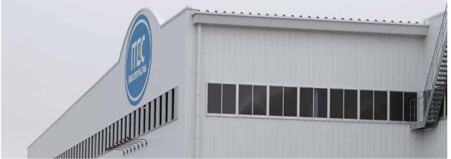
(株)アイ・テック相馬工場（外壁工事）福島県相馬市
