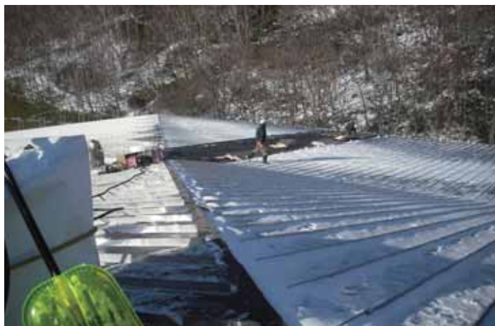
屋根施工は厳寒期。毎日仕事始めは雪かきから
