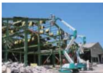
図2 丁寧な解体工法
