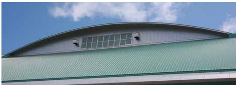
越屋根（ドーマー）の壁面は1枚1枚大きさが微に異なる
