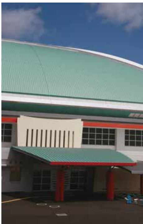
正面玄関上のキャノピーはR-T工法で施工
