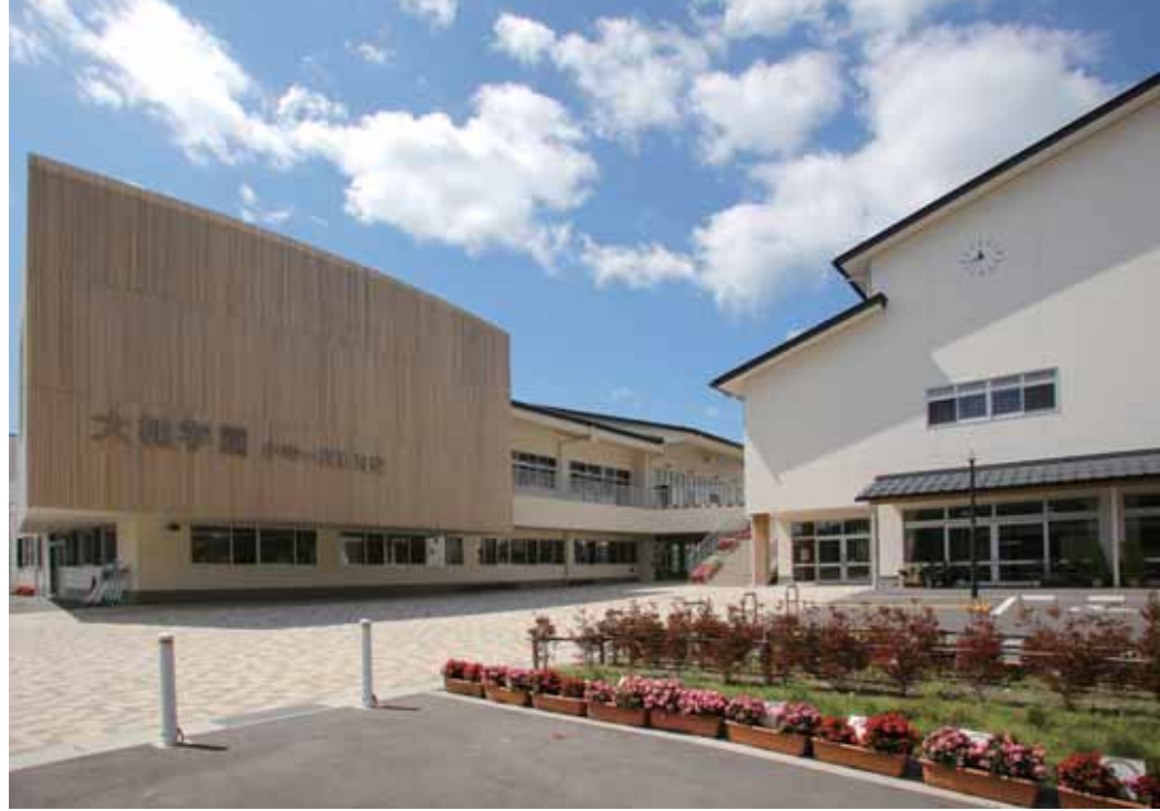
アプローチの広場
