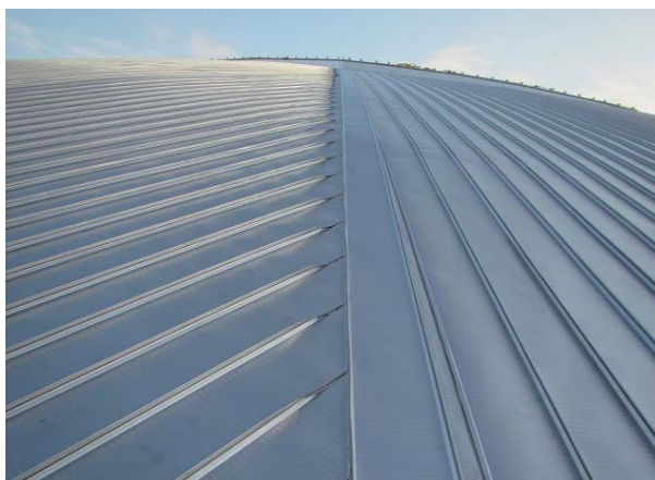
シーム溶接のラインも美しい屋根面
