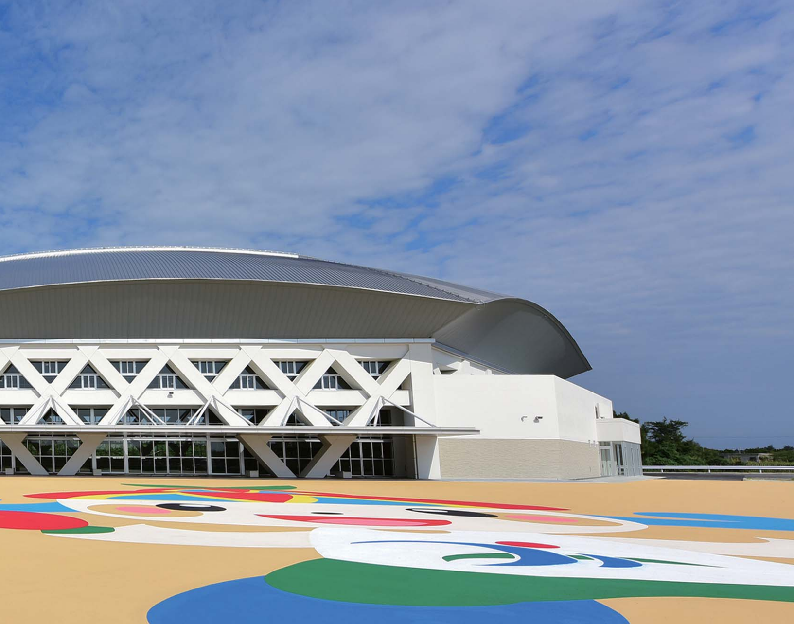
斜め柱が生み出す構造的な美しさは、一方で沖縄の建築によく見られる「花ブロック」を彷彿とさせます
