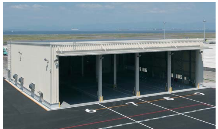
ドリームリフター・オペレーションズ・センター (DOC2) (愛知県常滑市) ●屋根仕様/丸馳折版Ⅱ型 フッ素樹脂ガルバリウム鋼板 t=0.8mm 2,013㎡ 折版W-500 フッ素樹脂ガルバリウム鋼板 t=0.8mm 196㎡ ●外壁仕様/折版F-200Ⅱ型 フッ素樹脂ガルバリウム鋼板 t=0.8mm 1,594㎡ サイディングS フッ素樹脂ガルバリウム鋼板 t=0.5mm 32㎡ ●設計・施工/東急建設(株)
