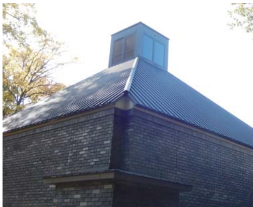
外壁に地元・藤岡産の黒瓦。屋根はアルミ型材による瓦棒葺き
