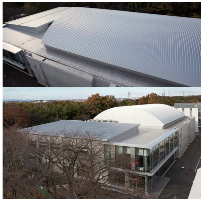
桐蔭横浜大学 体育館 (神奈川県横浜市) 【アリーナ棟】●屋根仕様/立馳SX-40 フッ素樹脂ガルバリウム鋼板 t=0.5mm 1,198㎡ ●外壁仕様/インバンドPro フッ素樹脂ガルバリウム鋼板 t=50mm 303㎡ 【柔道場】●屋根仕様/立馳SX-40 フッ素樹脂ガルバリウム鋼板 t=0.5mm 561㎡ ●外壁仕様/インバンドPro フッ素樹脂ガルバリウム鋼板 t=50mm 120㎡ ●設計/清水建設(株)一級建築士事務所 ●施工/清水建設(株)
