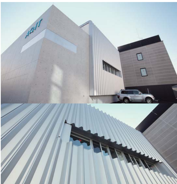
(仮称) イトマンスイミングスクール東京強化校 (東京都多摩市) ●屋根仕様/ダブルバック工法 上弦材:丸馳折版Ⅱ型 カラーガルバリウム鋼板 t=0.8mm 2,010㎡ 下弦材:丸馳折版Ⅱ型 ハイレタンSGL t=0.8mm 2,010㎡ ハイタフルーフィングシステムEP t=1.14mm 141㎡ ●設計/㈱梓設計 ●施工/大和ハウス工業(株) ※無溶接タイトフレーム採用物件
