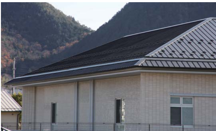
美濃市立美濃病院外来棟及び健診棟増築 (岐阜県美濃市) 【外来棟】●屋根仕様/立馳スピードロック フッ素樹脂ガルバリウム鋼板 t=0.5mm 681㎡ 【検診棟】立馳スピードロック フッ素樹脂ガルバリウム鋼板 t=0.5mm 121㎡ ●設計/㈱デザインボックス ●施工/青協・西村JV
