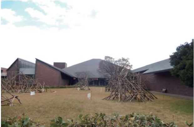
千葉県立美術館では、埋め立て地での建設を考慮し、軽量化を図るために屋根は鉄骨造の上に、ALC板、天然スレート葺きで施工
