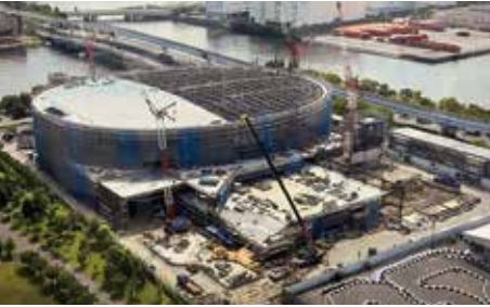
工区を南北に分け、写真左側の北工区からダブルバックを施工。南工区は鉄骨にタイトフレームを設置中
