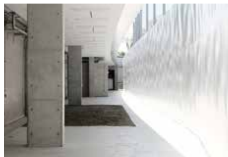
東京藝術大学彫刻棟増築 (2023)
