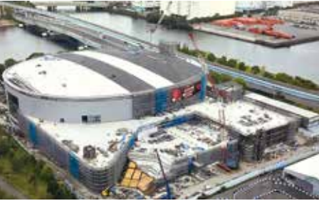
北工区はR-T工法が終わり、南工区はR-T工法の下地ができたところ
