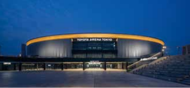
3階「GATE PLAZA」からメインエントランスを眺める。頂部の庇がライトアップされビーコンをイメージした外観を引き立てている
