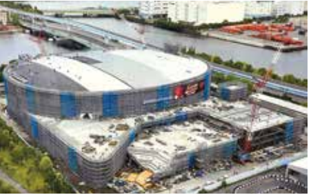
北工区は野地板を張り終わりR-T工法施工中。南工区はダブルバック施工後、一部野地板を張り始めている
