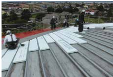
既存屋根の上にバックアップ材を敷く
