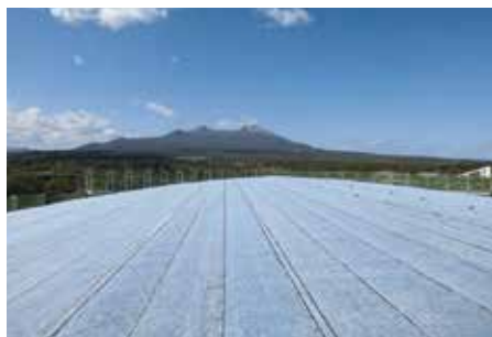
ゴムアスルーフィング敷き終わり
