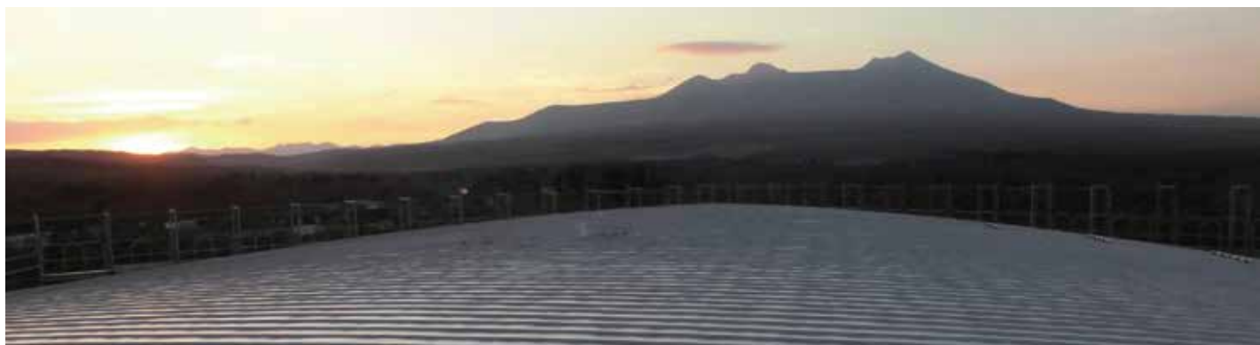
屋根改修ほぼ完了。駒ヶ岳を望む
