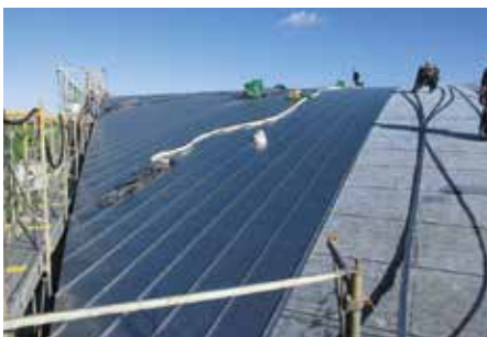
R-T屋根材施工の様子
