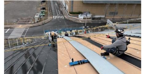
南側の成型機から出てくる屋根材を葺く様子を上から見る
