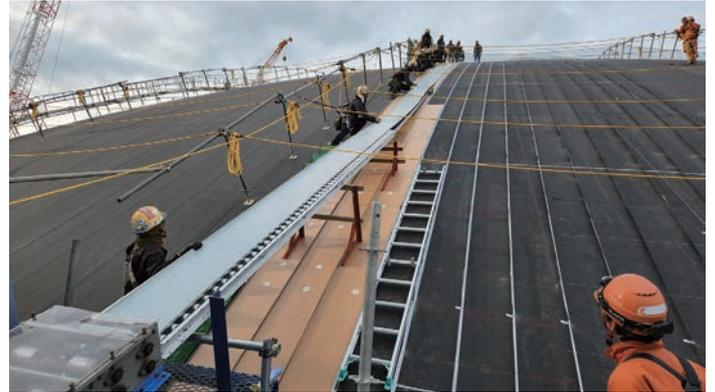
1枚目の作業の様子。南側に置いた成型機から屋根材を引き出して葺いていく
