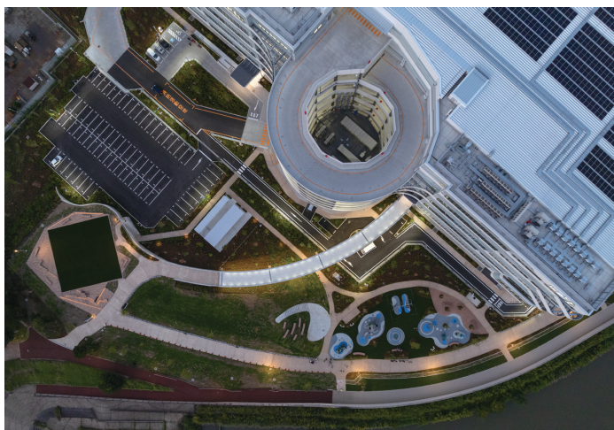
上空から見る広場と建物
