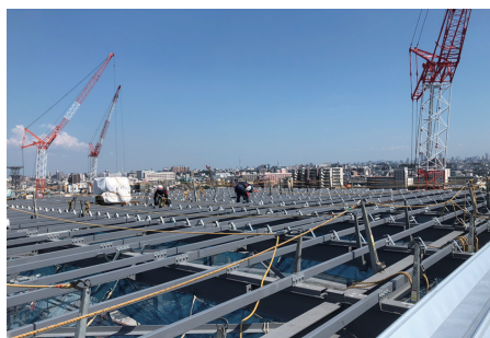
組み上がった鉄骨にタイトフレームを設置
