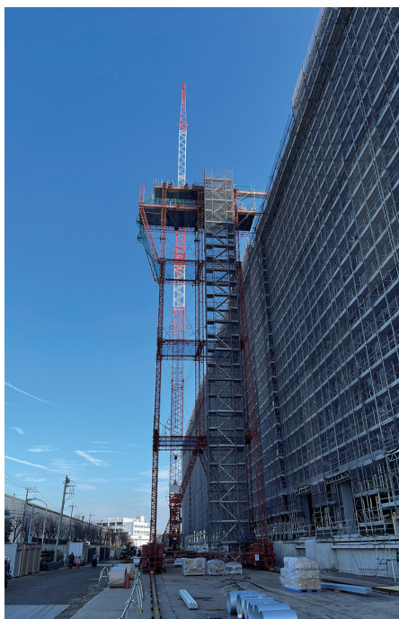
建物に沿ってレールの上を動く移動構台。構台を地上約45mの所に設置し上部で作業
