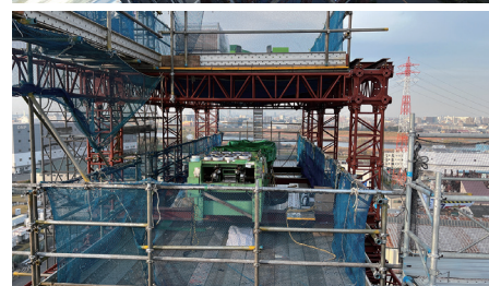
2層の移動構台。上階に材料をセットするアンコイラーと切断機が並び、下階から成型された材が屋上に引き出される（写真上）。下階の成型機（写真下）
