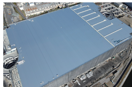
上弦材施工の様子。白いラインは上弦材と下弦材の間に入れる断熱材。断熱材を敷いた上に上弦材を葺く
