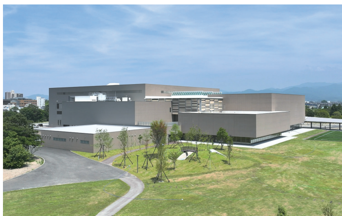
南側広場からの眺め。それぞれの箱は無落雪工法を採用した陸屋根としている。屋根にはシート防水ハイトフEGを採用
