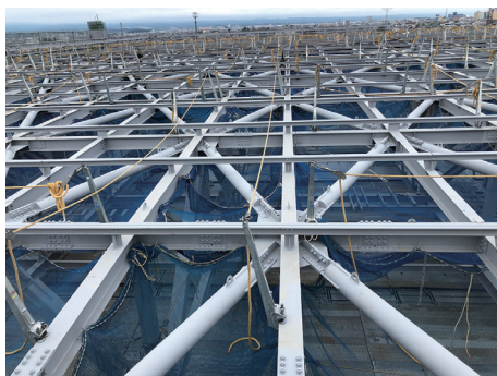
メインアリーナの工事に着手する前の進捗と安全確認。高さ20mの作業なので安全対策に万全を期す
