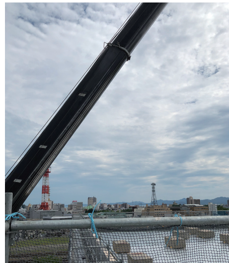
50mのラフタークレーンでどこまで物が届くかを確認
