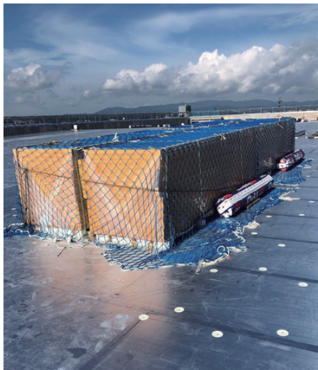
断熱材を敷き終わって養生をしている。周辺に線路もあり、資材が風で飛ばされないようにネットをかけロープで厳重に固定
