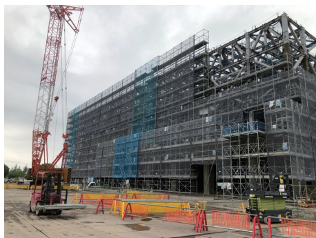
クローラークレーンでデッキやハイタフEGの材料を荷揚げ。作業スペース、荷揚げスペースは比較的広い
