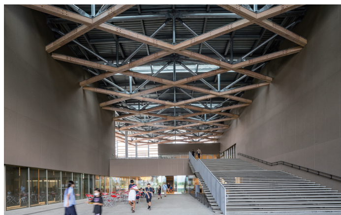
中央にある半屋外スペース「ヨリドマ」。鉄骨と木によるハイブリッド構造の大空間広場。奥の2階突き当たりのデッキは、冬季は「かっちょ」（津軽弁）と呼ばれる防雪柵が付けられる
