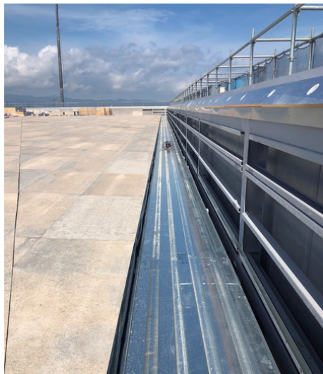
メインアリーナの樋と立ち上がり部分。雪を溜める無落雪工法のため立ち上がりは約1.5m
