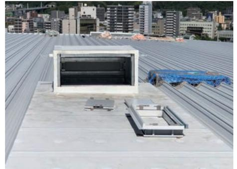
屋根鳩小屋。メンテナンス時の安全性も考慮してエックスロン防水で止水
