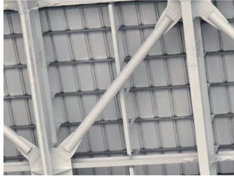
南側天井面。屋根裏面が仕上がりとなるため、白く塗装し中間吊子が客席から見えないように仕上げている
