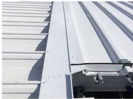
北西面取合部。左は北側で折版F-80、右は西側で丸馳折版ロックII型。境界部に水切りを取り付けている
