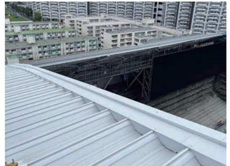
風で雨水が水上からフィールドに落ちないように水上包みに立ち上がりを設けている
