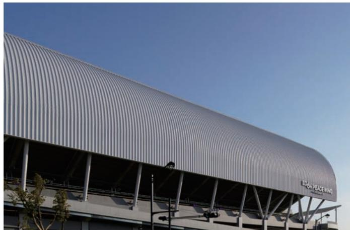
南面屋根。前面の城南通りを走る車に反射光を軽減するために、さざ波リブを入れて光を拡散させている
