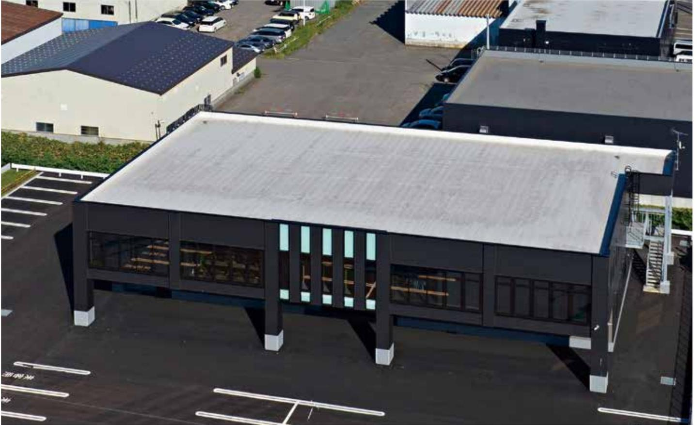
陸屋根は全面にエックスロン防水での施工
