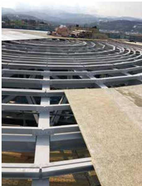
鉄骨に野地板敷き込み
