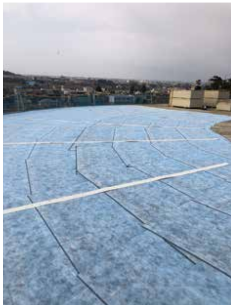
防湿材敷き込み
