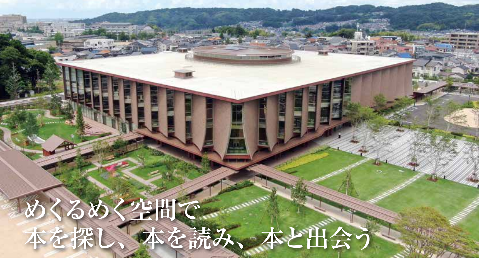
南側から見た外観。アースカラーのタイルが貼られたコンクリートパネルとガラスのカーテンウォールが雁行して配置されている。外壁のめくれた形状は本をめくる様子をイメージ。屋上の円形屋根の部分、外周部のキャノピーにR-T工法が使われている
