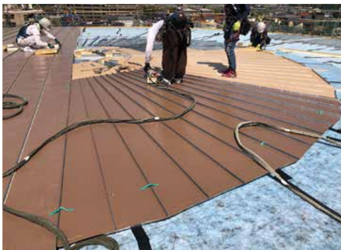
扇形部分溶接の様子
