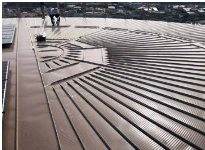
扇形部分施工の様子
