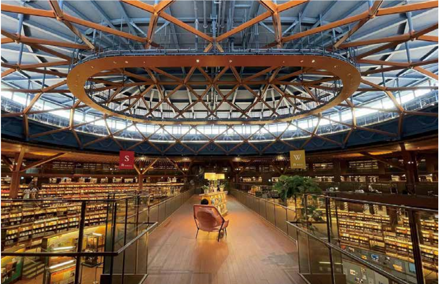
吹き抜けのグレートホール上部に架かるブリッジ。柱のない空間を実現した屋根の架構
