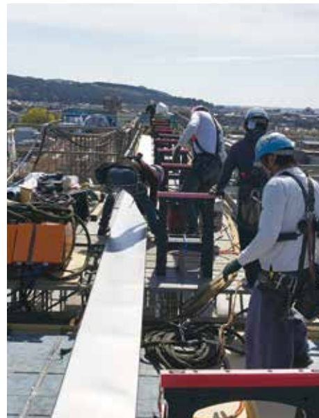
R-T 屋根材成型の様子
