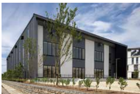
体育館棟。外壁・屋根ともに立馳 SX-40 を使用。シンプルなストライプ状のデザイン
