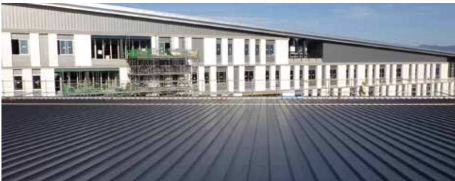
体育館棟の屋根。立馳SX-40。谷樋に止水性の高いエックスロン防水を使用 (施工中写真)
