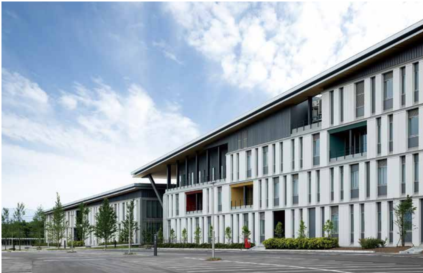
外壁。白いパネルはサイディングハイシャドー、開口部の下は目地無しスパンドレル、屋根との間に立馳 SX-40 を使用した特徴あるデザイン
