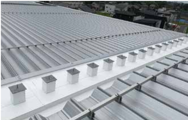
大学校舎棟の屋根。屋根全体で受ける雨水を分散させるために設けた谷樋
