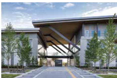
2つの学校の真ん中に設けられた大屋根の架かる共通のエントランス。学生たちはここから各学校に入る
