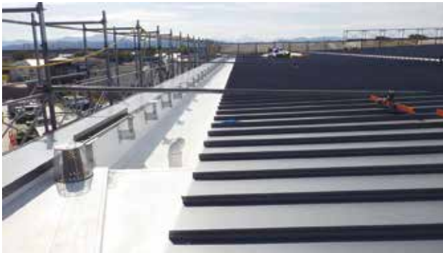
体育館棟の屋根。立馳SX-40。谷樋に止水性の高いエックスロン防水を使用 (施工中写真)
