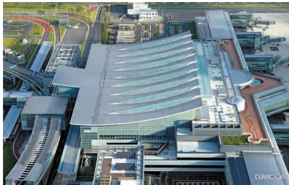
東京国際空港 国際線旅客ターミナルビル 東京都
