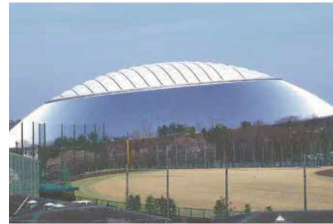
西武ドーム 埼玉県
