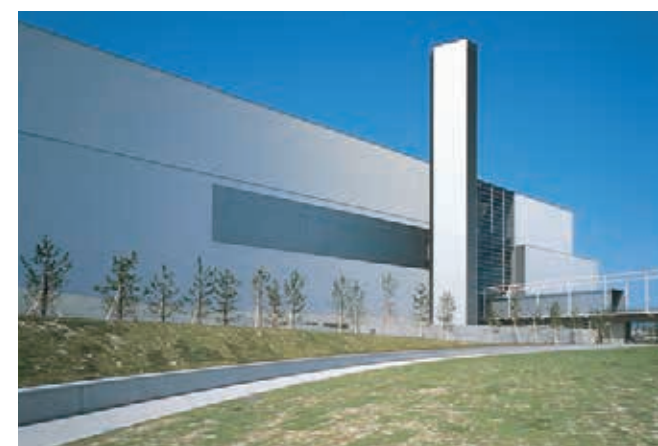
広島市環境局中工場 広島県
