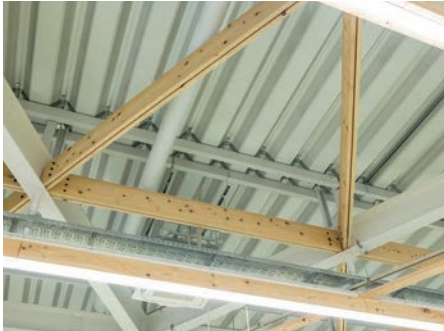
工場棟内部 下弦材を逆成型にし、カラー面が見えるように施工
