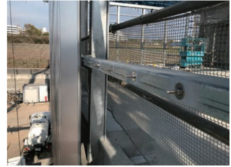
室外機置場(外壁特寸折版貼) 胴縁へ先行穴あけをしてビス剣先や穴あけ部に錆が 発生しないようにし、ボルト・ナットには錆止め補 修を施し固定
