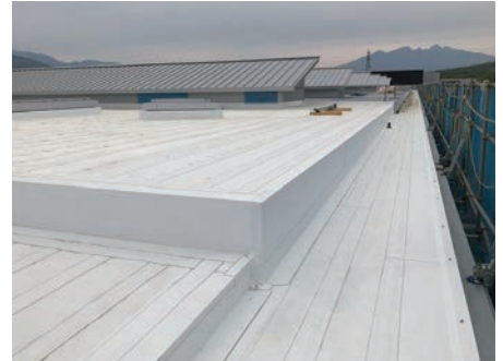
事務棟屋根・外周庇(エックスロン防水) 段差が多く、複雑な納まり
