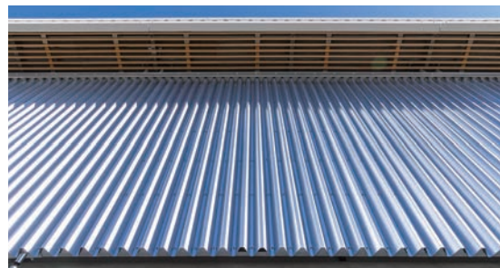
工場棟西側壁面 折版外壁中空層を利用した自然換気が織り込まれた外壁の特寸折版
