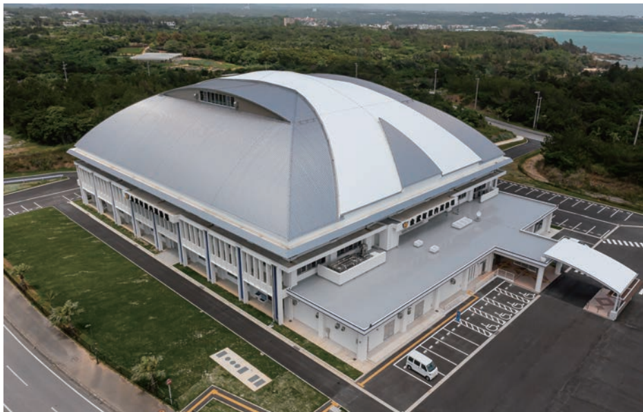
海から至近の距離に位置する。白い膜屋根は南北方向にかかり、東西面の屋根にはドーマーが設けられ入母屋風の形状になっている
