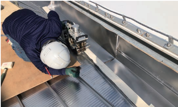
膜屋根と金属屋根の納まり部分の溶接作業
