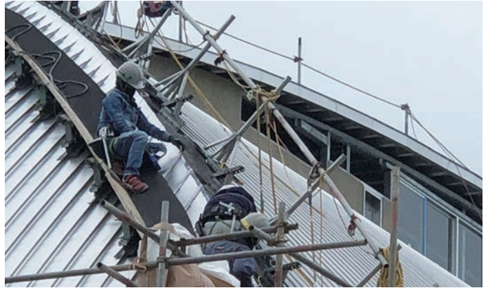
棟部分の屋根葺き。座位で安全に作業できるように作業台を設置している
