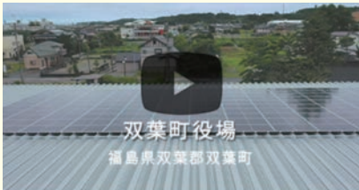
No.326 双葉町仮設庁舎建設工事
