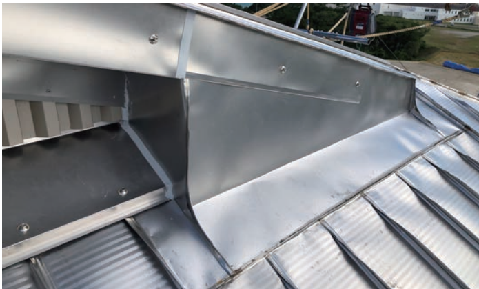
妻側端部、ドーマー部分、下屋根の取り合い
