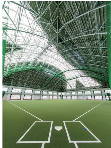
膜屋根と開口部からの光で明るい内部。鉄骨造の屋根架構。野球の内野練習やフットサル、ゲートボールなどができる広さ
