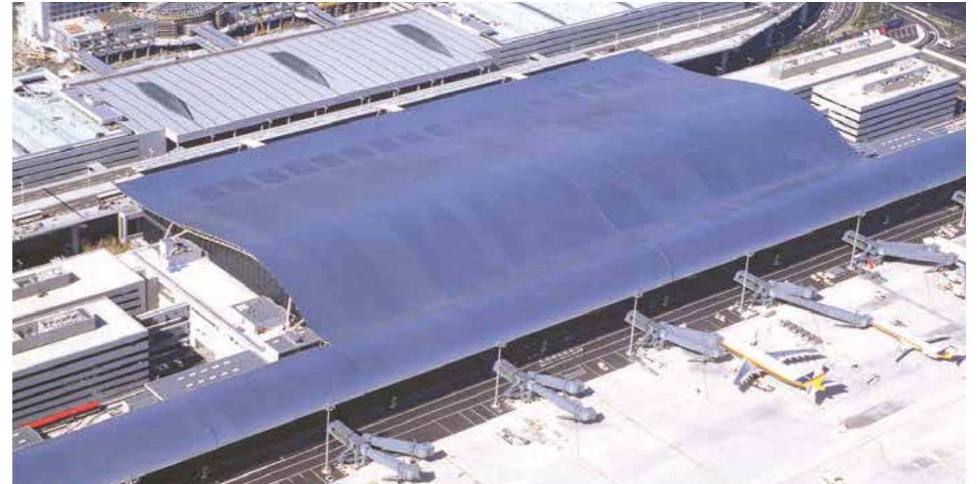
関西国際空港ターミナルビル 大阪府
