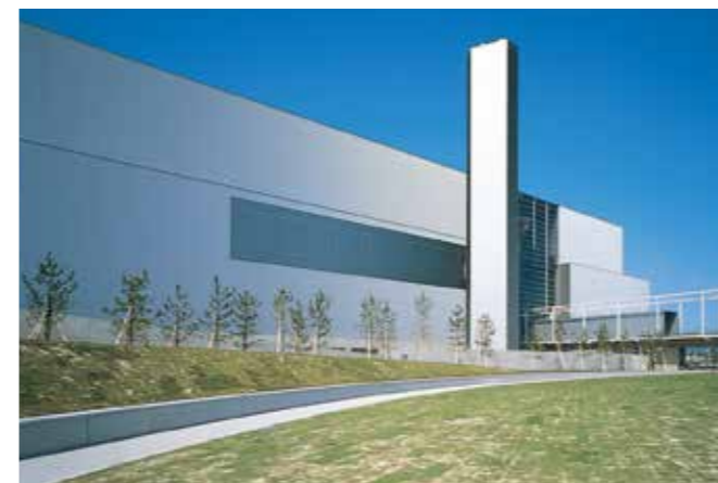
広島市環境局中工場 広島県
