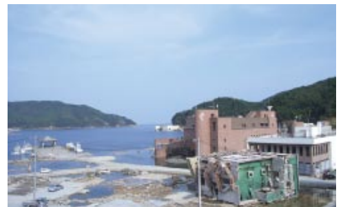
女川町。高台から見ると、海岸近くは浸水している様子がわかる。手前にビルが横転している
