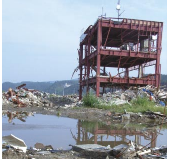
南三陸町の防災対策庁舎
