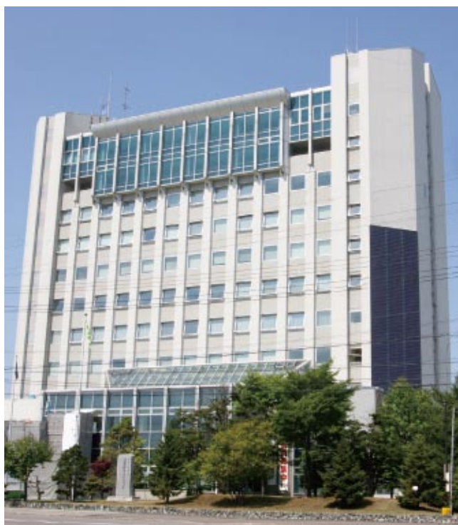
滝川市役所庁舎省エネ設備設置工事（北海道滝川市）
