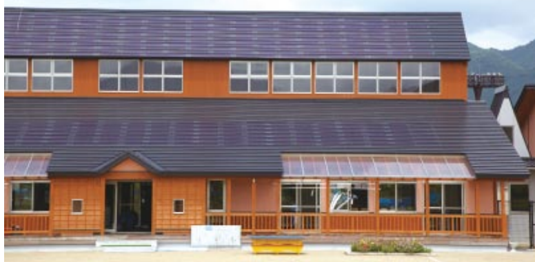
統合保育所建築事業太陽光発電設備工事（福島県南会津郡）
